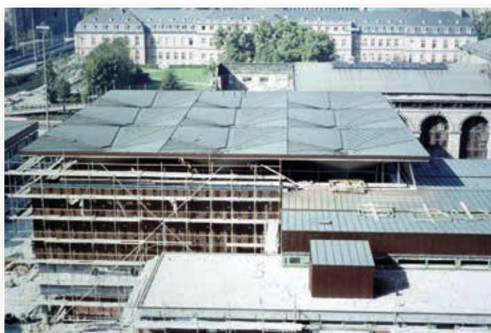
Abb. 2: Das neue Bibliotheksgebäude im Bau
