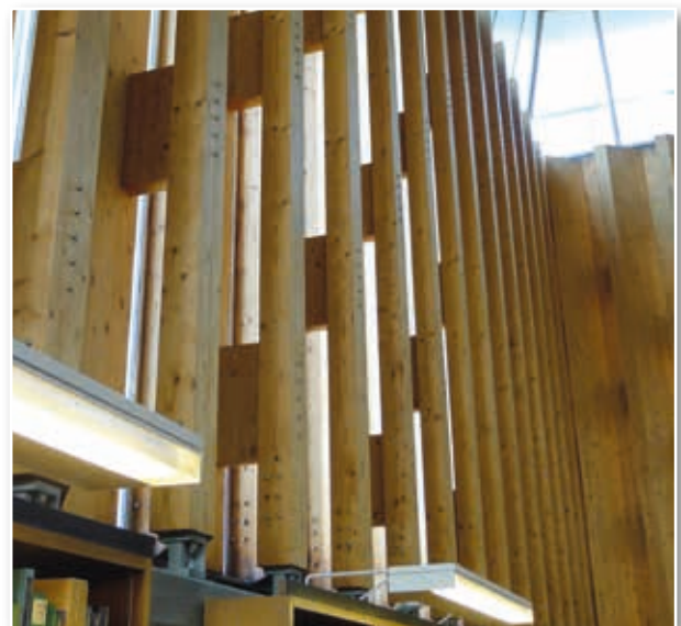
Abb. 5: Architektonische Details der Lesesaalfassade von innen
