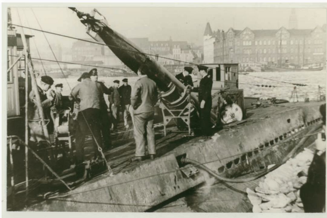
Abb. 5: Torpedoübernahme durch ein U-Boot
